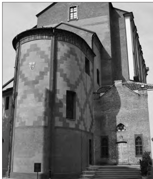
Restauro abside della chiesa parrocchiale 2010
